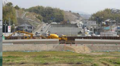
田辺バイパス工事
